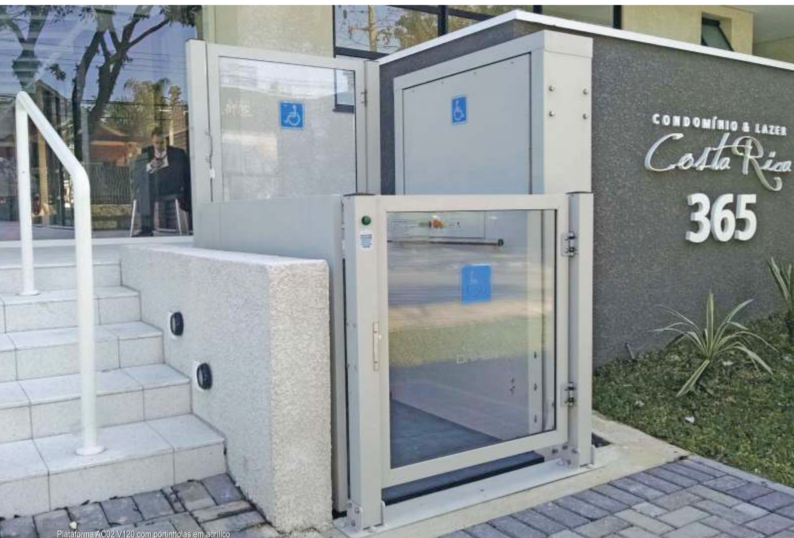
Plataforma AC02 V120 com portinholas em acrílico
